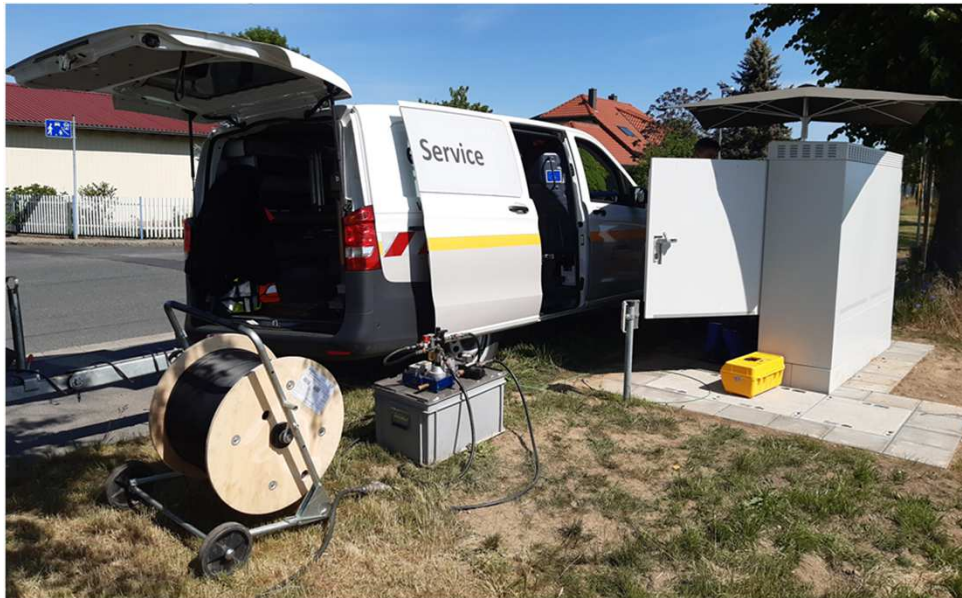
Bild: Einjetten und Spleißen am MFG in Skaup (ENSO Netz GmbH)
