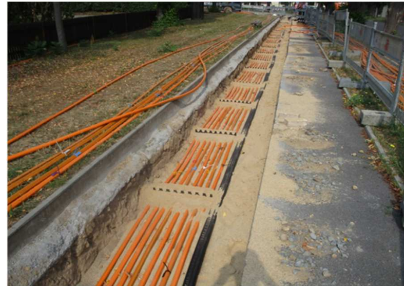
Bild: Trasse mit Mikrorohrverbänden in Zabeltitz (ENSO Netz GmbH)
