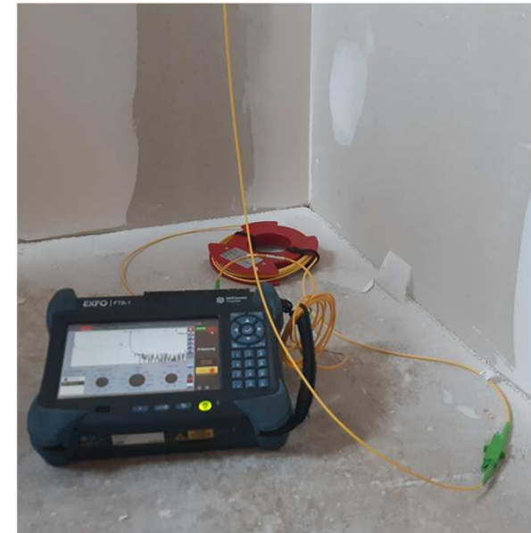
Bild: Messung beim Kunden (ENSO Netz GmbH)
